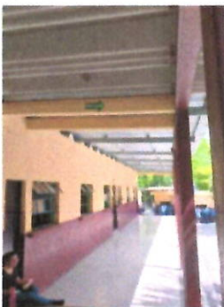
ESTRUCTURA DE TECHO Instalacion de estructura metálica para soporte de cubierta de lámina, por cambio de DURALITA.
