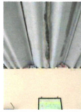
CUBIERTA DE LAMINA Sustitución de cubierta de Duralita en mal estado
