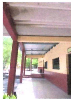
ESTRUCTURA DE TECHO Instalacion de estructura metálica para soporte de cubierta de lámina, por cambio de DURALITA.
